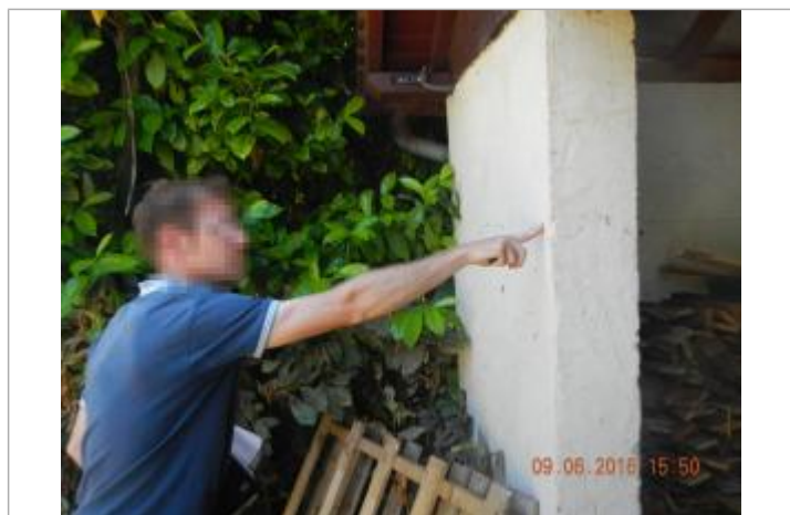
Ligne horizontale sur l'abri à l'arrière de la maison
