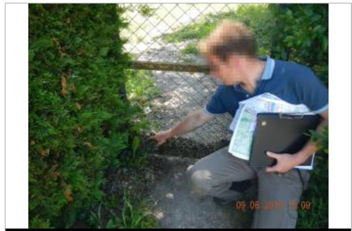
Laisse de branches et feuilles sur le portillon
