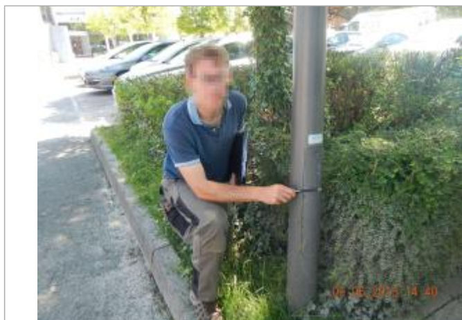
Trace laissée par la crue sur un lampadaire et sur les buissons à côté
