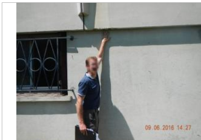
Ligne horizontale laissée par la crue juste sous le plafond du sous-sol
