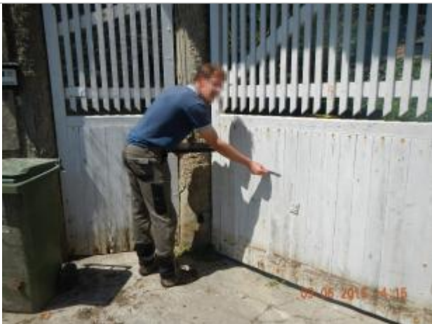
Ligne horizontale laissée par la crue sur le portail de la propriété
