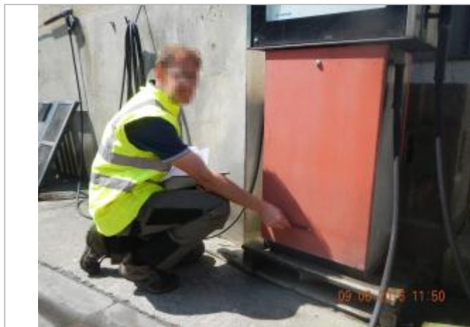
Ligne horizontale laissée par la crue sur une pompe à l'arrière du bâtiment
