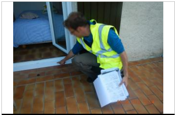
Limite basse de la baie vitrée
