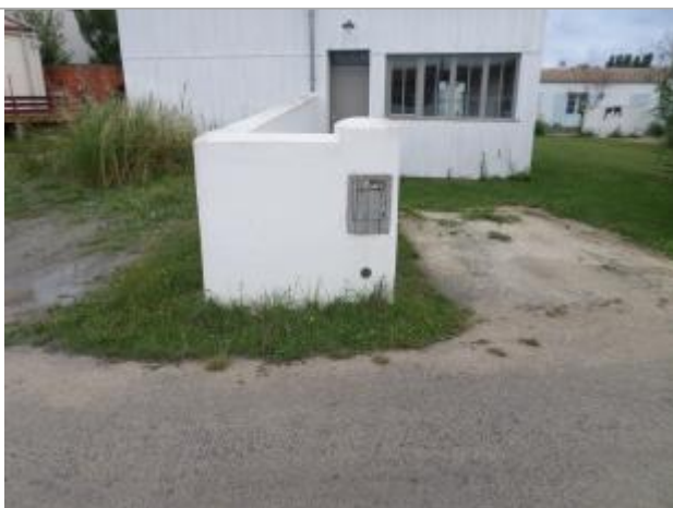
Macaron Xynthia sur muret
