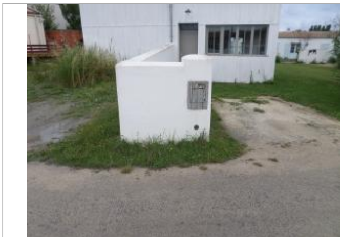
Macaron Xynthia sur muret
