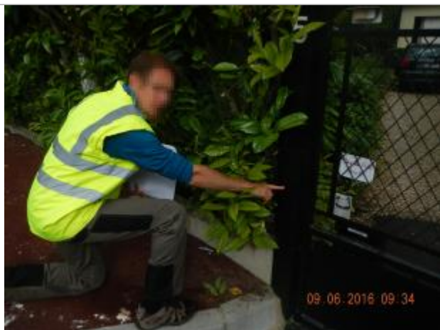
Laisse de crue laissée sur le portail
