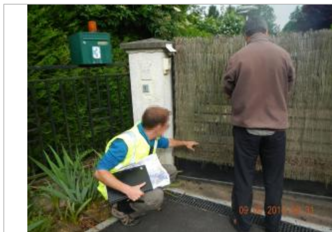
Laisse de crue laissée sur le portail
