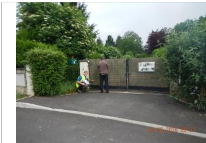
Laisse de crue sur le portail
