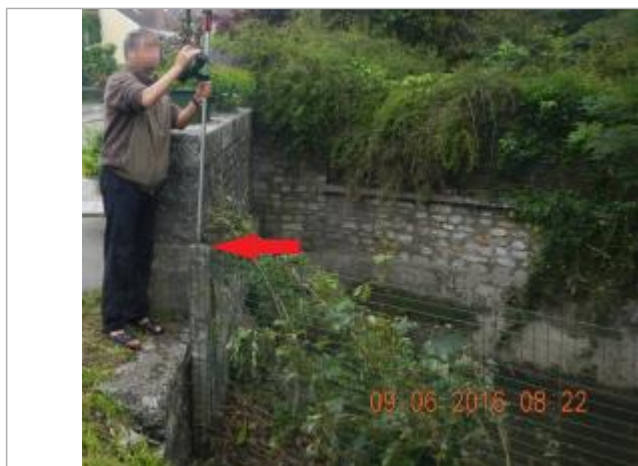
Laisse végétale déposée sur le haut du grillage de la rive gauche juste avant le pont
