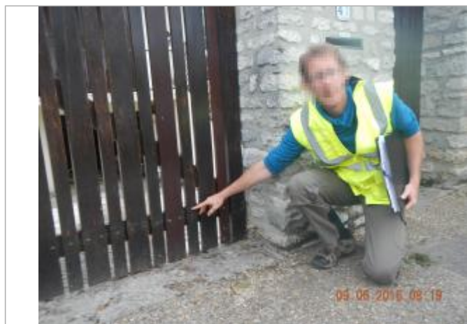
Ligne horizontale laissée par la crue sur le portail de la propriété
