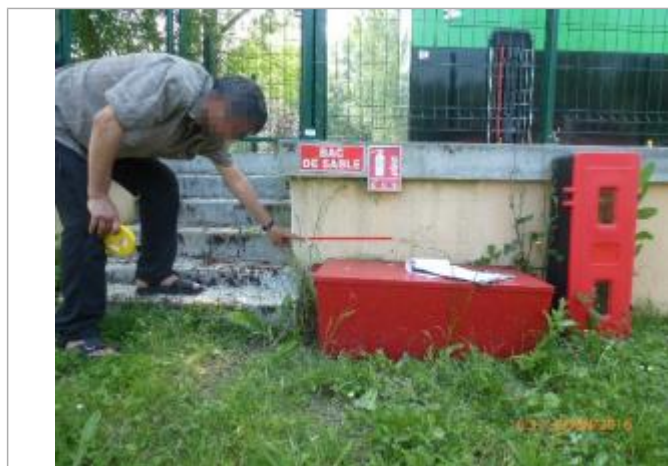
Marque horizontale laissée par la crue au dessus d'un bac de sable sur le parking
