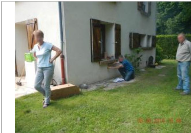
Maison entièrement inondé
