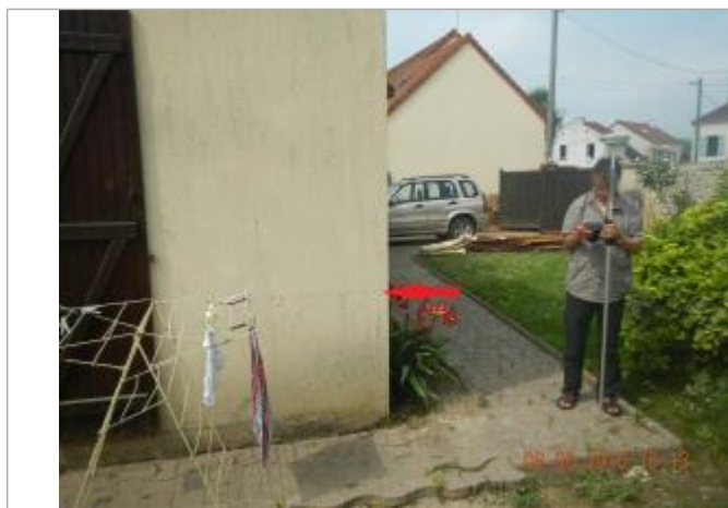
Ligne horizontale laissée par la crue sur le mur extérieur de la maison
