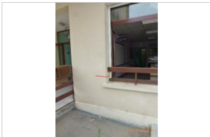
Laisse sur le rebord d'une fenêtre, façade principale, côté entrée droit
