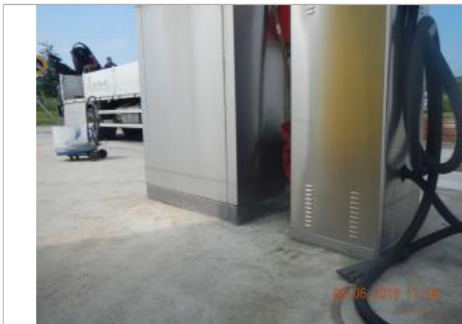
Ligne horizontale très nette laissée par la crue sur les pompes du parking
