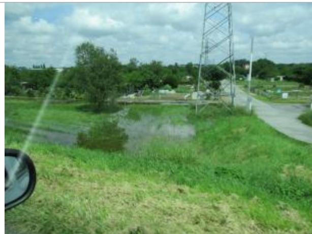
Site pendant la crue de juin 2016 (source : CEREMA Normandie-Centre)
