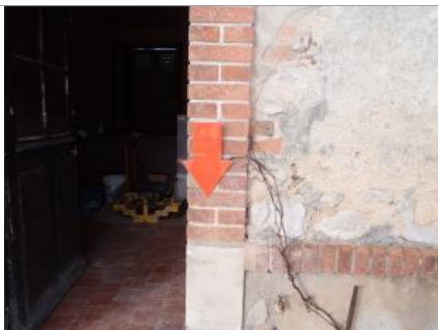
Détail du repère (source : CEREMA Normandie-Centre)
