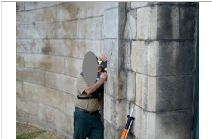
Repère de 1866(6), situation (culée rive droite aval)
