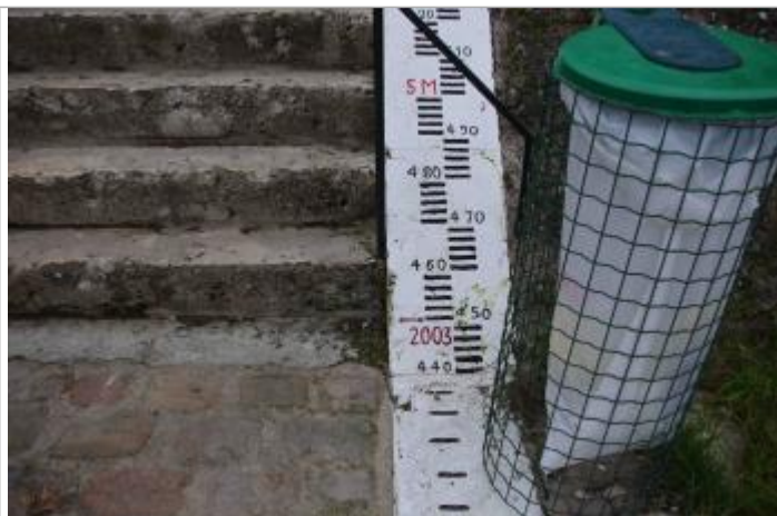
Marque de la crue de 2003 (source : Maison de la Loire 37)
