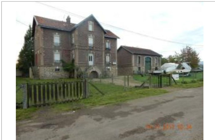
Maison éclusière (photo SPC SACN)
