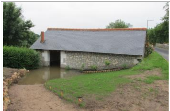
Lavoir pendant la crue du 02/06/2016, depuis la route de Vernou (source : Maison de la Loire 37)
