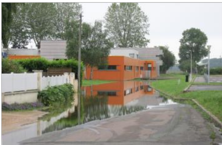
Prise de vue depuis chemin des poulains, le 02/06/2016 (source : Maison de la Loire 37)
