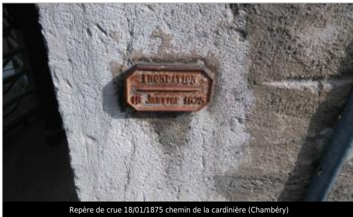
Repère de crue 18/01/1875 chemin de la cardinière (Chambéry)
