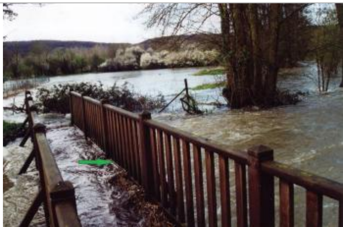
Le niveau entre le plancher et la bordure inférieure de la rambarde(photo ISL)
