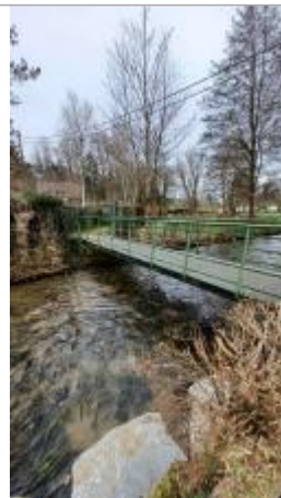
Passerelles sente des Courtieux
