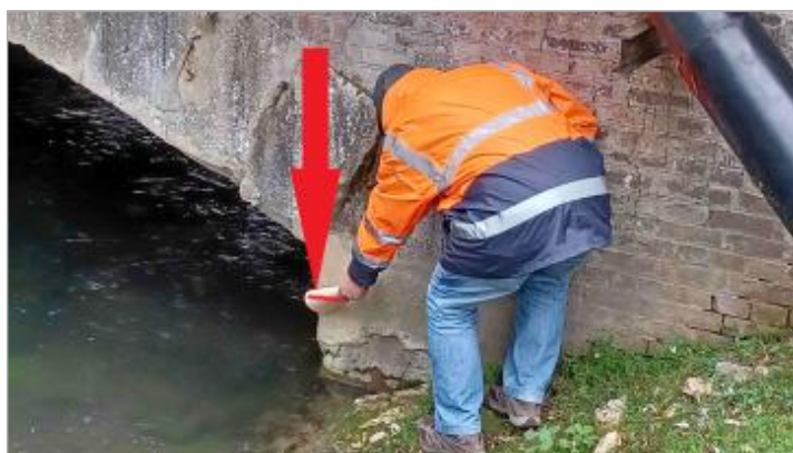
Environ 15 cm sous l'angle entre le mur de soutènement et le départ de la voûte coté amont rive droite.
