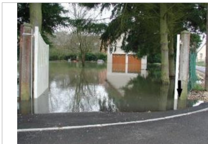
Portail du 2 rue des sources (photo ISL)
