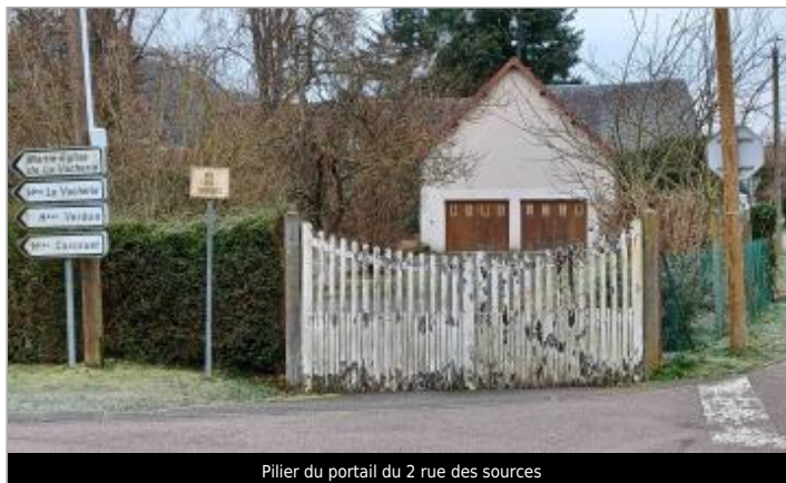
Pilier du portail du 2 rue des sources
