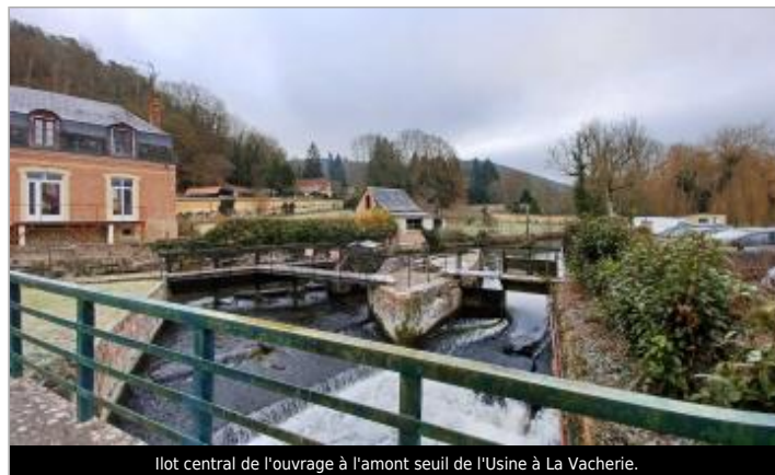
Ilot central de l'ouvrage à l'amont seuil de l'Usine à La Vacherie.
