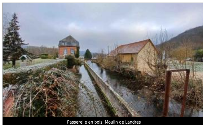
Passerelle en bois, Moulin de Landres
