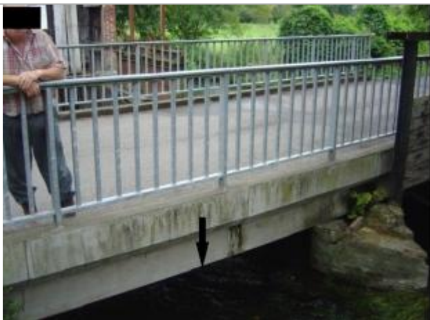
Pont rue des Prés (photo ISL)
