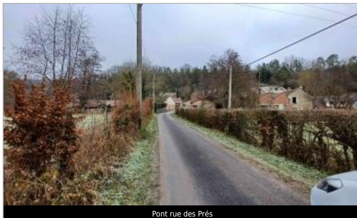
Pont rue des Prés
