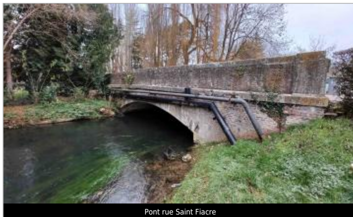
Pont rue Saint Fiacre
