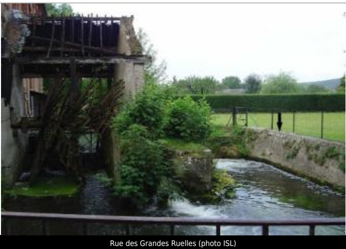
Rue des Grandes Ruelles (photo ISL)
