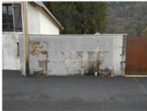
Mur d'enceinte - maison éclésièrè de Casamène
