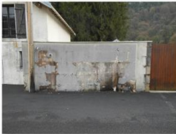
Mur d'enceinte - maison éclusière de Casamène
