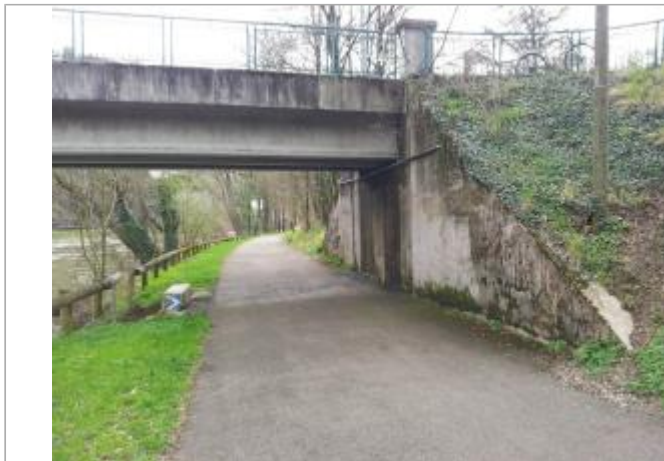
Pile de la passerelle Mazagran, rive droite
