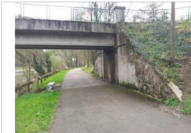
Pile de la passerelle Mazagran, rive droite
