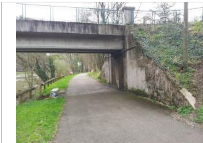
Pile de la passerelle Mazagran, rive droite
