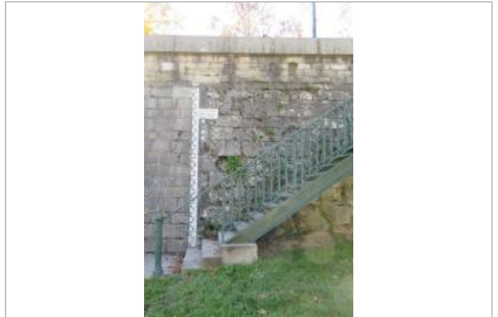
Echelle limimétrique du pont de la République
