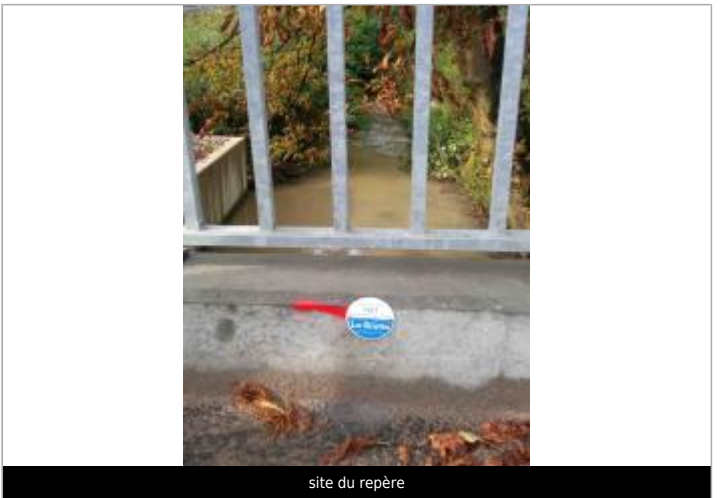
site du repère
