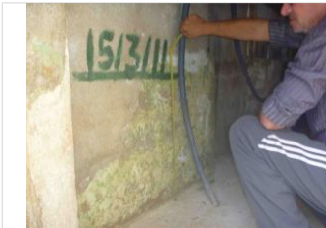
Rue de la Grande Fontaine 4, crue 15 mars 2011, hauteur 67 cm
