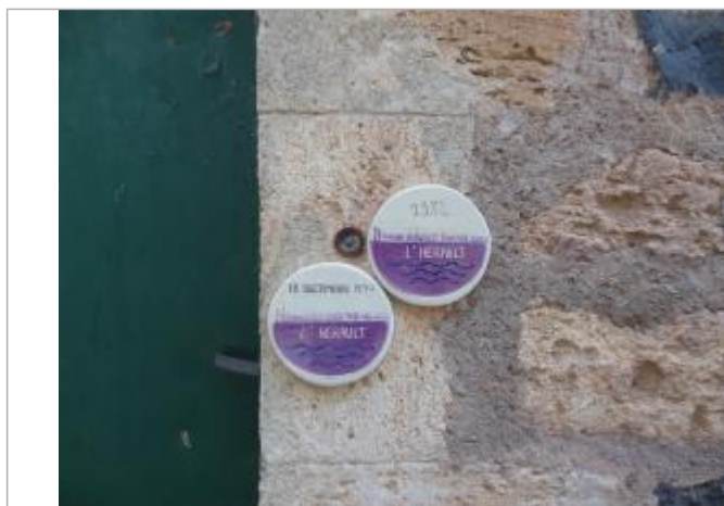
repères posés sur le bâtiment
