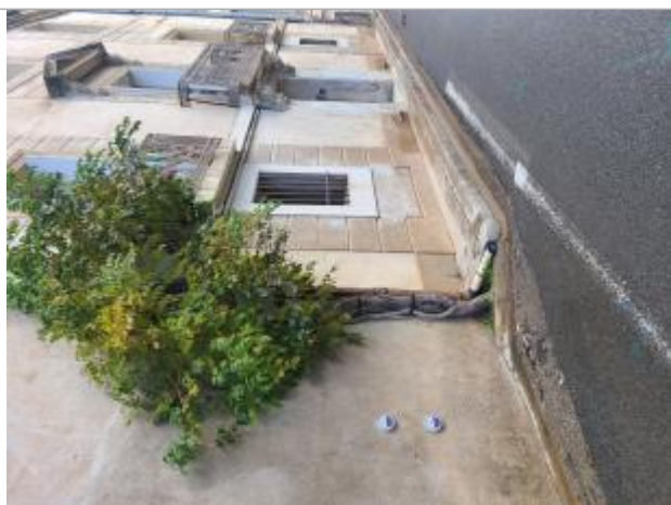
Repères de crue posés sur la façade du n°20
