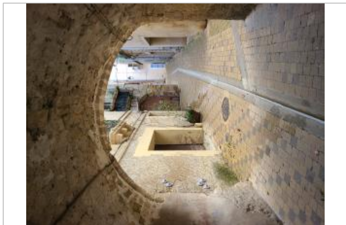
Repères de crue posés sur la façade à gauche après le passage
