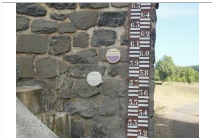
vue des différents repères sur la digue
