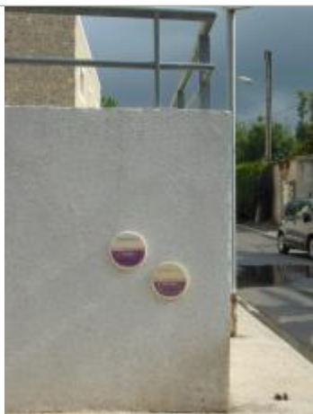
repère posé sur mur extérieur ehpad
