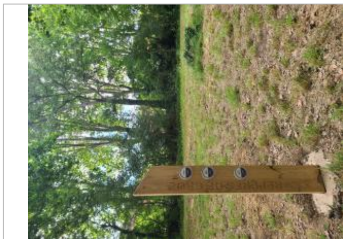
Totem de crue monté des repères de crue
