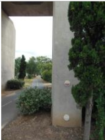
vue des repères sur pile de pont
