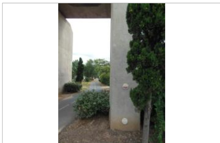
vue des repères sur pile de pont
