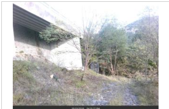
3 ème pile du pont en descendant le chemin
