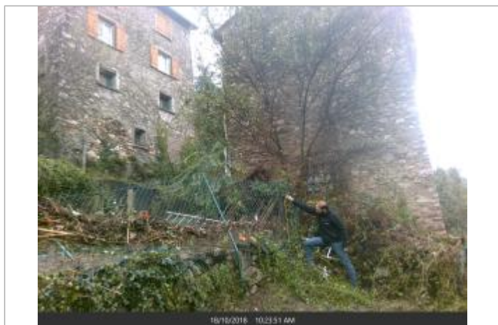
Angle du mur du jardin
